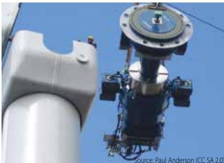
*Cet énorme assemblage d'une boîte de vitesses et d'un frein à disque, de 12 tonnes, est levé à la grue à une hauteur de 60 mètres, puis installé dans cette nacelle d'éolienne.*
